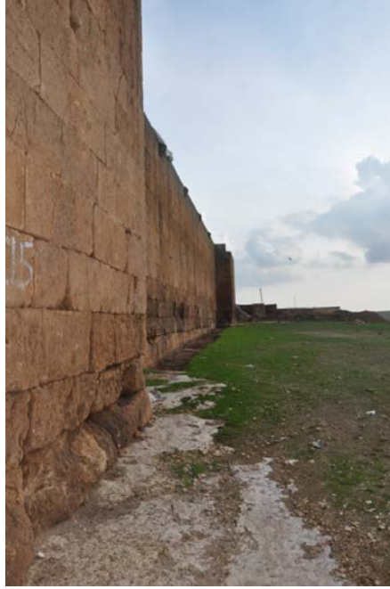
Şekil 56. Batı Cephesi Zemin Kazısı Ve Ana Kaya
