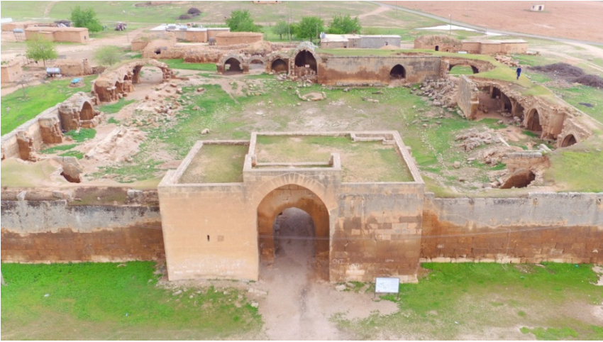
Şekil 5. Kuzey Cephesi ve Avlu (Y. Küçük, 2017)
