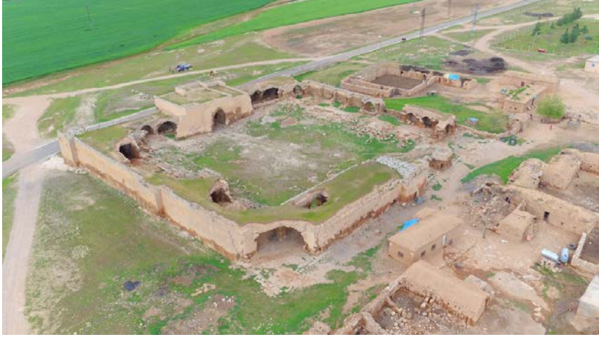
Şekil 6. Ba'rûr Hanı Hava Fotoğrafi –Güneybatı Köşesi ve Avlu (Y. Küçük, 2017)
