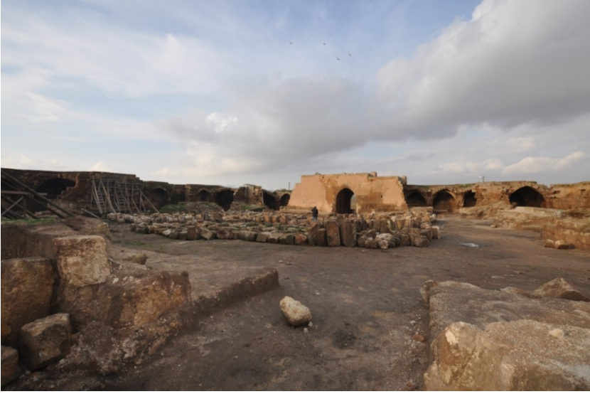
Şekil 13 Avlu - Kuzey Batı, Kazı Ve Temizlik Çalışmaları Sonrası
