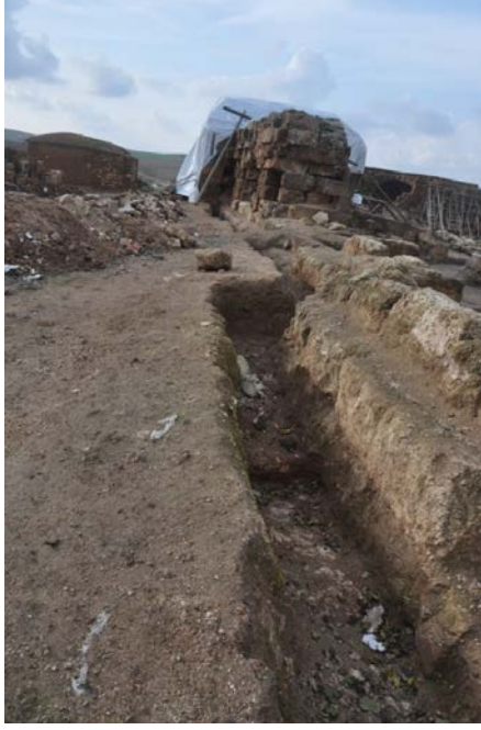
Şekil 55. Güney Cephesi, Zemin Kazısı
