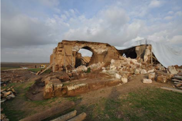
Şekil 46. Güneybatı Köşe Mekânı, Kazı Ve Temizlik Çalışmaları Sonrası
