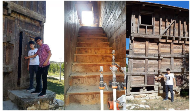
Şekil 15. Bey Ambarı 1'in İkinci Giriş Kapısı ve Tahıl Bölmesinin Dışa Açılan Küçük Penceresi
