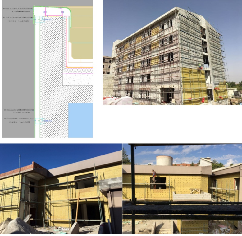
Şekil 8: Mevcut ve ek yapılarda ısı yalıtım malzemesi uygulama süreçleri (Nurettin Aykutlu arşivinden; 2018)
