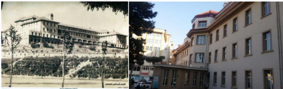
Şekil 3: Soldaki resim: Ankara Numune Hastanesi'ne ait özgün cephe görüntüsü ( https://www.istanbulmuzayede.com/urun/341430/ankara ) giriş tarihi (03.08.2019). Sağdaki resim: Ankara Numune Hastanesi'nde yalıtım uygulaması yapılan cephe (Mehmet Şener arşivinden; 2018)
