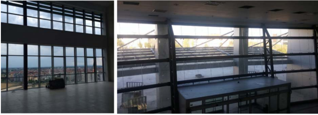
Şekil 1: Devlet Hastaneleri'nde ciddi ısı kayıplarının oluşabileceği büyük cam yüzeyli atrium ve galeri boşluklarına bir örnek (Soldaki resim: Edirne Sultan 1. Murat Devlet Hastanesi–Burcu Biricik arşivinden, 2015, Sağdaki resim Eskişehir 600 yataklı Devlet Hastanesi-Neslihan Türkmenoğlu Bayraktar arşivinden, 2018).
