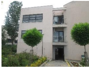
Şekil 8. Metal Yangın Merdiveni (Demir 2016)
