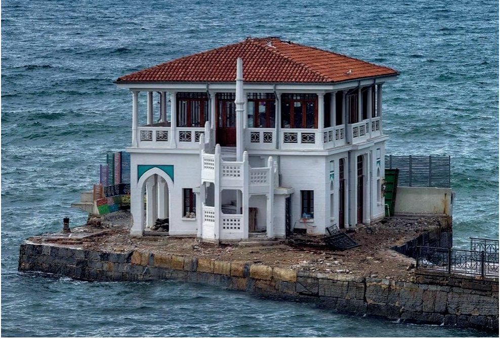
Görsel 8: Moda İskelesi, doğu cephesinden görünüm. (Cemal Emden, 2019)
