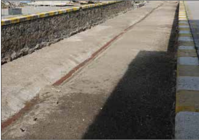
Fotoğraf 17: 3 ve 4 numaralı peronların arasındaki demir su borusu ve tuğla dizisi (Kazı Arşivi). / Iron water pipe and brick row between platforms 3 and 4 (Excavation Archive).
