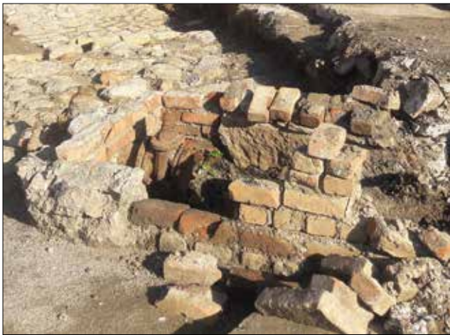
Fotoğraf 15: Su vanası etrafına örülmüş tuğlalar (Kazı Arşivi). / Bricks around the water valve (Excavation Archive).
