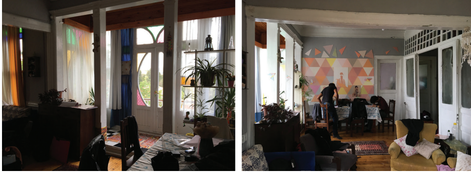
G. 10: Sunazırı Sokağı Köşkü Balkon Doğramaları ve Sofa (GTÜ Restorasyon A.B.D. Arşivi, 2018).
