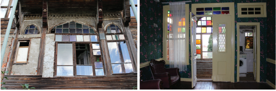
G. 5: Sunazırı Sokağı Köşkü rüzgarlığı (GTÜ Restorasyon A.B.D. Arşivi, 2018).
