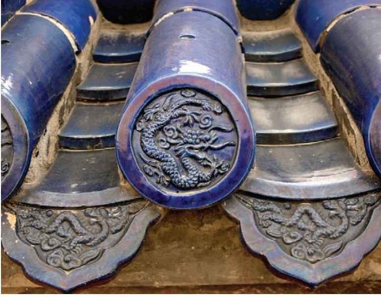
Fot. 28: Beijing, Cennet Tapınağı'nda çatı kenarlarında ejderha figürlü çiniler ( https://www.pbase.com/image/31309872 /20.01.2021)
