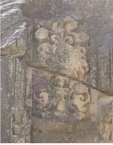
Fot. 14: Taşkesen, güney cephe bitkisel süsleme (A. Denknalbant Çobanoğlu, 2012)
