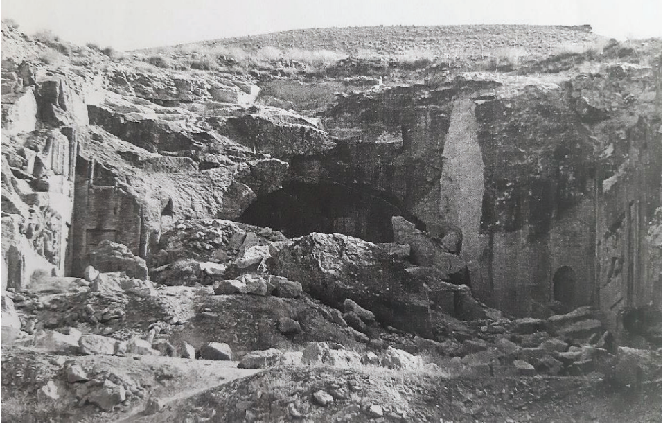
Fot. 31: Taşkesen, yapının üst bölümlerinden koparak yıkılan bölümler (Azad, 2011, 10.8)
