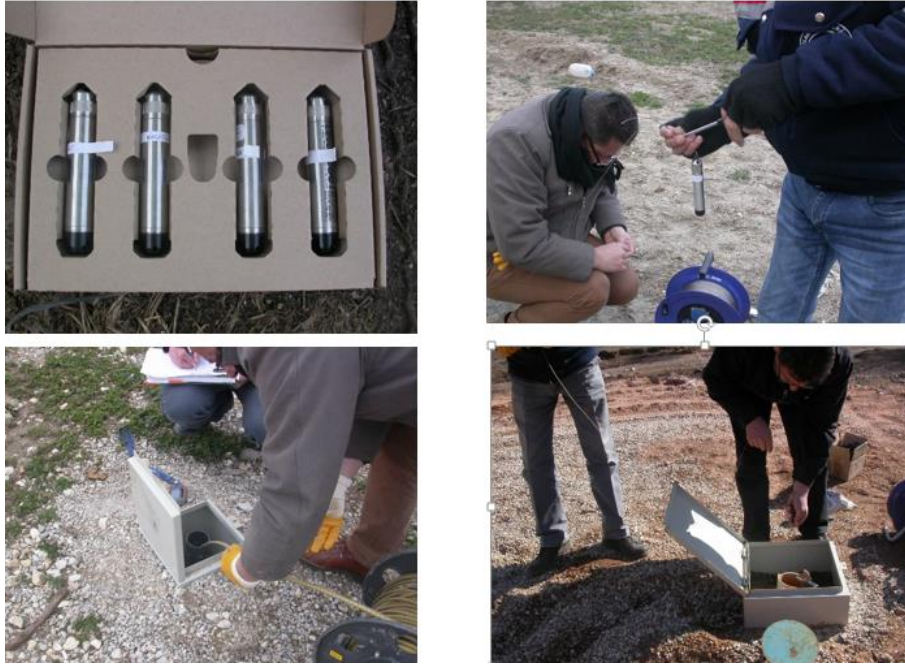
Şekil 4. Seviye kaydedicilerin kuyulara yerleştirilmesi
