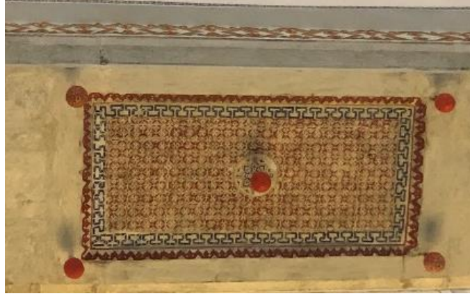
Şekil 3: Yıldırım Beyazıt Camii Bursa kemeri süslemesi- son restorasyon 2019
