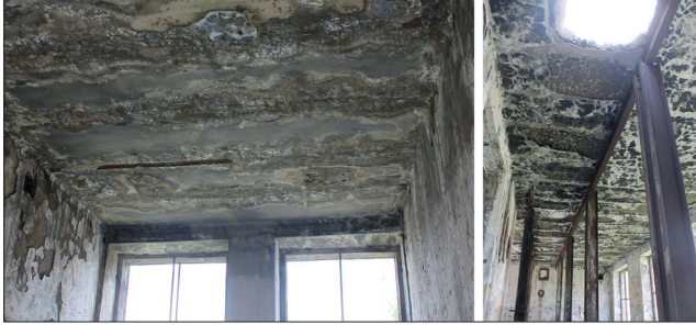
Fotoğraf 10: I profilli ve beton dolgulu tavan döşemesi / Concrete filled ceiling with I profiles
