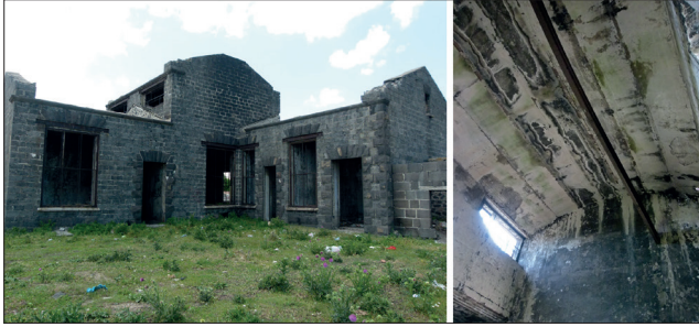
Fotoğraf 11: 105 no'lu mekanın üzerini örten beton dolgulu, çelik kirişli tonoz / Concrete filled and steel beam vault of the room 105
