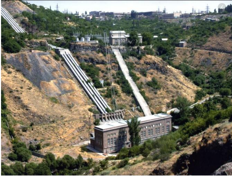
Foto 3. Sevan-Hrazdan Enerji Santral Kompleksinden Birisi Olan Kanaker HES'den Bir Görünüm
