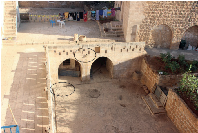
Foto 8: Geleneksel evlerdeki açık alanlara düşen yağış sularının toplanmasında kullanılan kanal ve oluklar.
