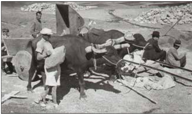
Figure 15: Transportation of stones to the construction site (IHTBV). / İnşaat alanına taşların taşınması (IHTBV)
