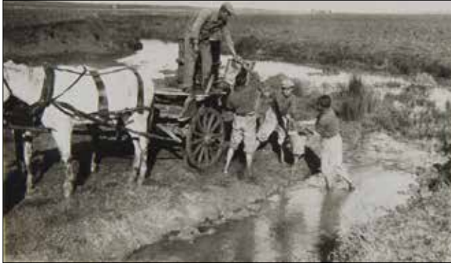
Figure 14: Transporting water from the river to the construction site in buckets before establishing the water canal (IHTBV). / Su kanalı inşasından önce nehirde inşaat alanına kovalarla su taşınması (IHTBV)
