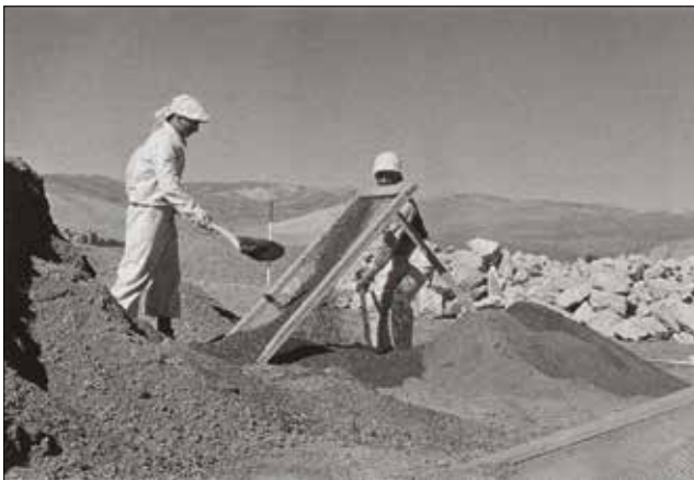
Figure 20: Sifting sand for mortar preparation (IHTBV). / Kireç söndürme aşaması (IHTBV)
