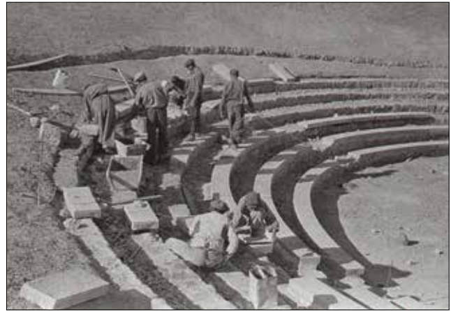
Figure 33: Construction of the sitting area of the open-air theater (IHTBV). / Açık hava tiyatrosunun oturma alanının inşası (IHTBV)
