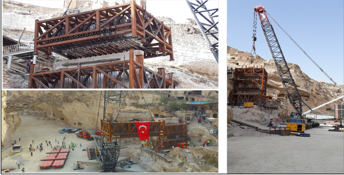
Fig. 8: Hasankeyf Orta Kale Kapısı'nın üç yapı bloğuna ayrılarak 650 ton kaldırma kapasiteli mobil vinçle yerlerinden kaldırılma aşaması çalışmaları
