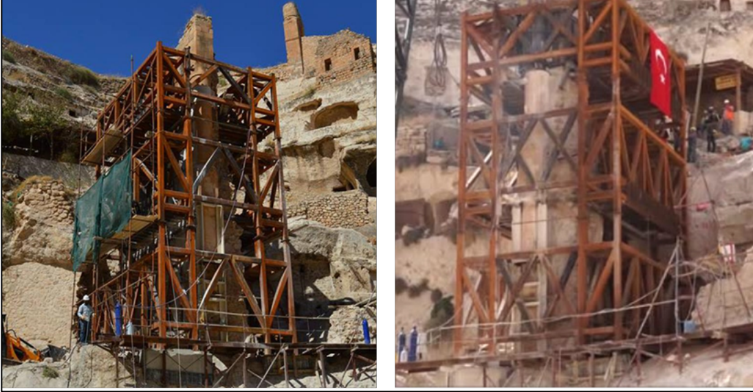
Fig. 7: Hasankeyf Orta Kale Kapısı'nı kaldırma ve taşıma için yapılan çelik taşıyıcı konstrüksiyon
