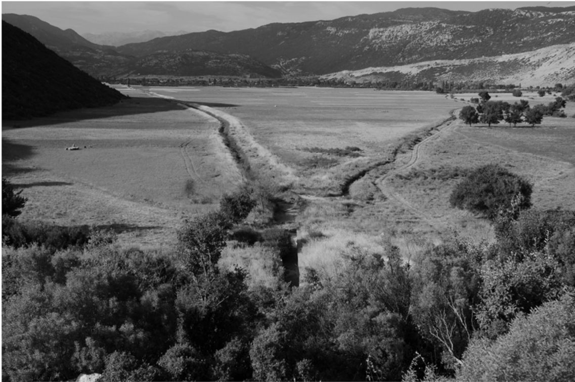
5. Bezirgan Ovası mit Entwässerungskanäle vom Süden (oberhalb des Tunnelseinganges)
