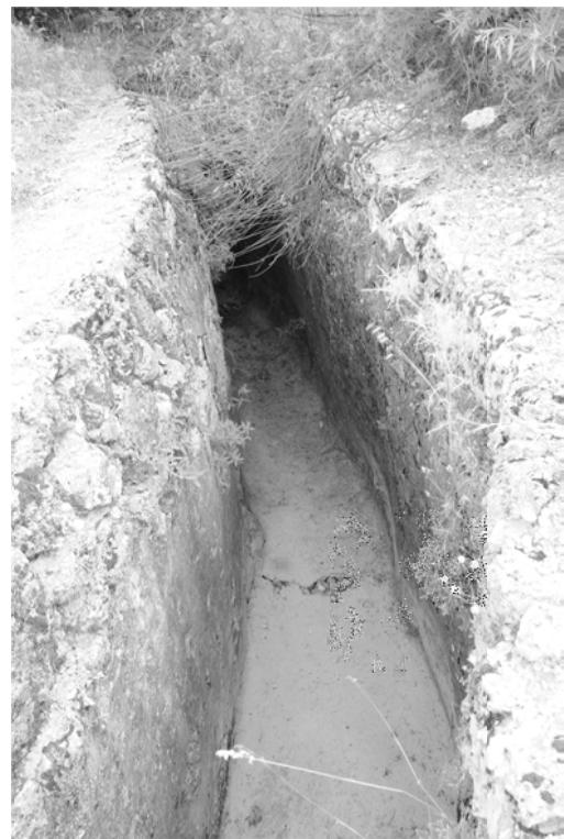
7. Der Eingang des Entwässerungstunnels
