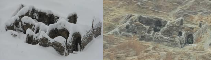
Şekil 56,57. Hüsrev Paşa Külliyesi Çifte Hamamı Kuzeybatı Genel Görünüşleri (Ş. Öztürk)
