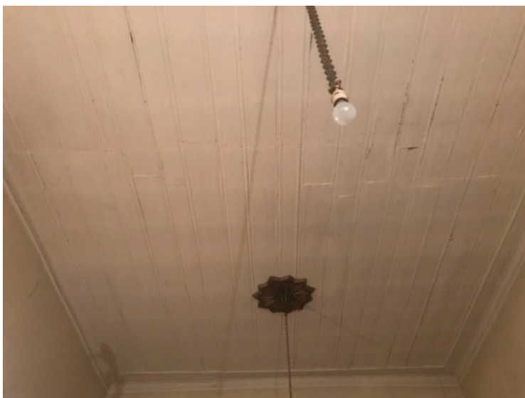
F. 5: Başoda's Ceiling of Bohcalian Mansion (Koşanlar, 2018)
