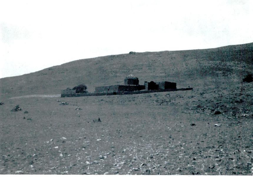
Resim 1 – Külliye'nin Havadan Köyü'nden görünüşü.
