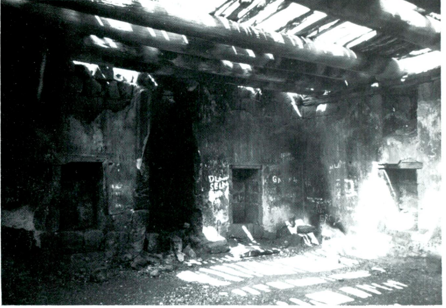
Resim 7 – Mutfađın üst örtüsü (içten).
