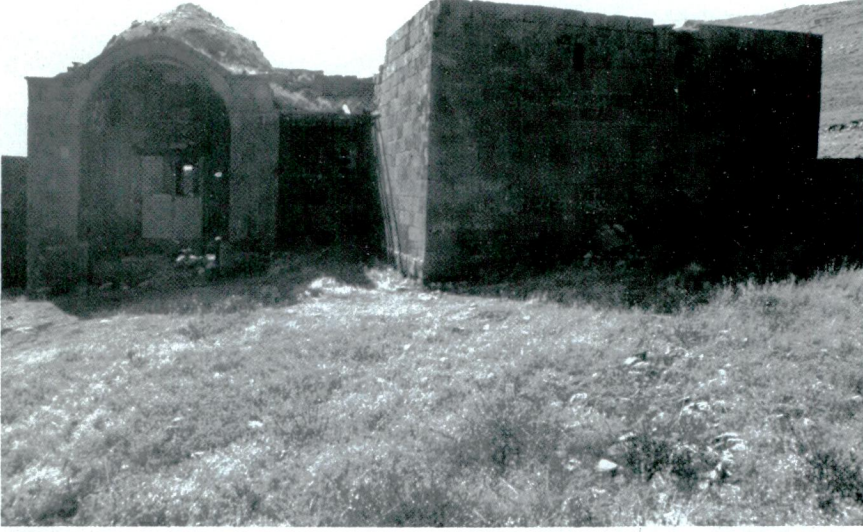
Resim 5 – Giriş eyvanı ve mutfak.
