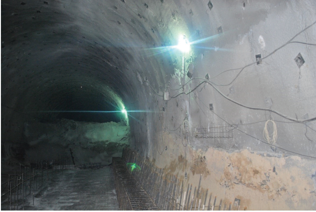
Şekil 9. Tünelin taban kemer betonunun tamamlanmış hali.
