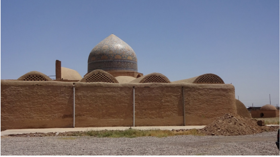
Resim 6: Batı cephesi ve güney kubbe (S. Şan, 2015)
