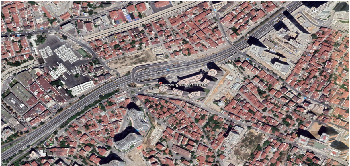
Şekil 10. 2020 Yılı Fikirtepe Metrobüs İstasyonu Bölgesi
