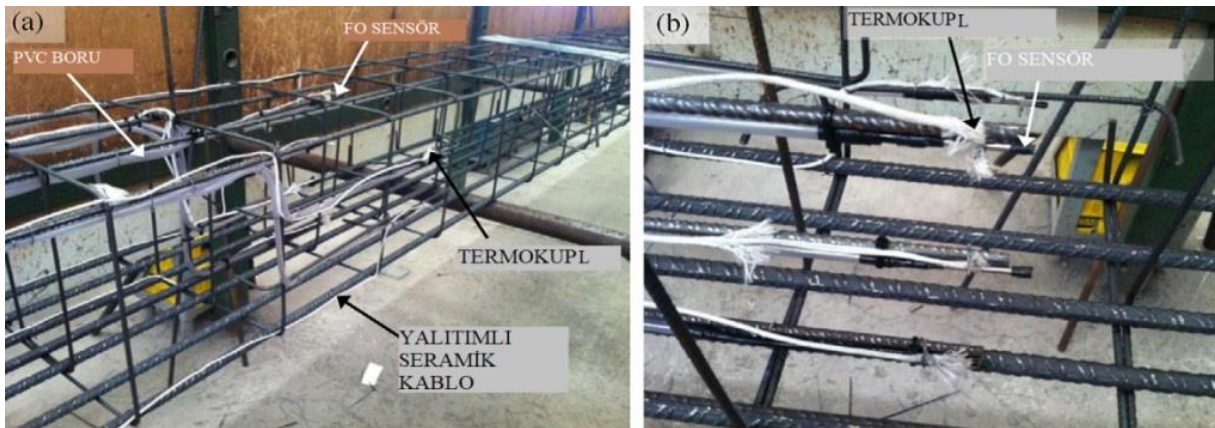
Şekil 1. Beton kirişin termokupllar ve fiber optik sensörleri ile donatılmasının genel görünümü (a) ve detayı (b) [9].
