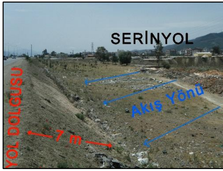
Foto 3. Çalışma Alanında Yelpaze Foto 4. Bedirge Kanalındaki Rüşubat ve Yüzeyinin 7 m Üzerine Kadar Yükselen ve Katı Atık Birikimi ile Arka Planda Kanal Akış Yönüne Dik Uzanan Yol Dolgusu Kapasitesini Düşüren Köprü Ayakları
