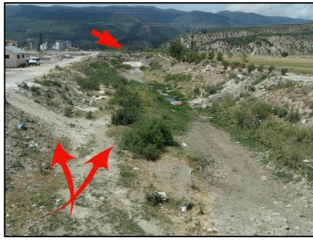
Foto 3. Çalışma Alanında Yelpaze Foto 4. Bedirge Kanalındaki Rüşubat ve Yüzeyinin 7 m Üzerine Kadar Yükselen ve Katı Atık Birikimi ile Arka Planda Kanal Akış Yönüne Dik Uzanan Yol Dolgusu Kapasitesini Düşüren Köprü Ayakları
