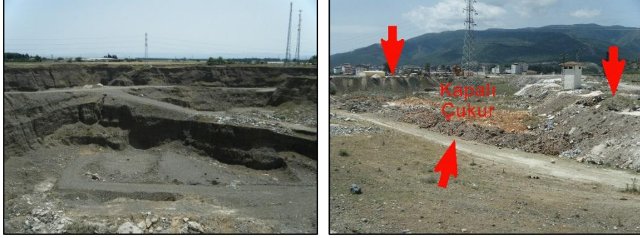
Foto 7. Paşaköy Güneybatısındaki Kum Ocaklarından Bir Görünüm Foto 8. Değişik Türden Molozların Gelişigüzel Biriktirildiği Depolama Alanı
