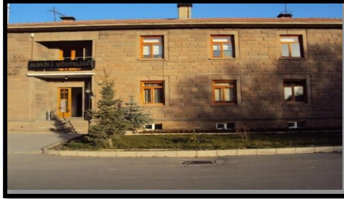
Fotoğraf 2.3. Erzurum Şeker Fabrikası Müdürlük Binası.
