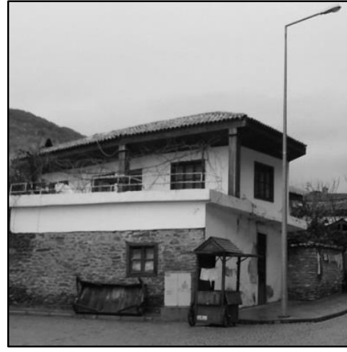
Fotoğraf 4. Cephe onarımı yapılmış bina örneği (Photograph 4. Sample of Buildings with facade restoration)
