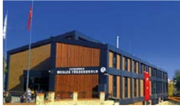
Şekil 5. SMYO Binası Genel Görünüm
