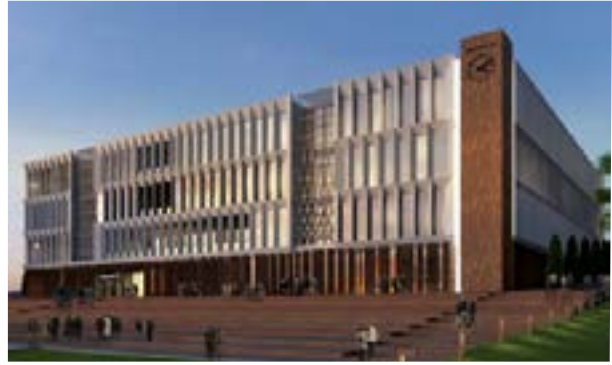
Şekil 9. Mühendislik Fakültesi Laboratuvar Binası Genel Görünüm
