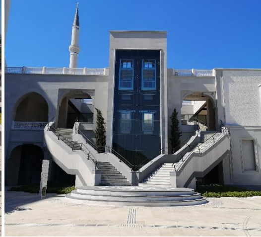
Şekil 6. Ön Avluya Çıkan Merdiven.
