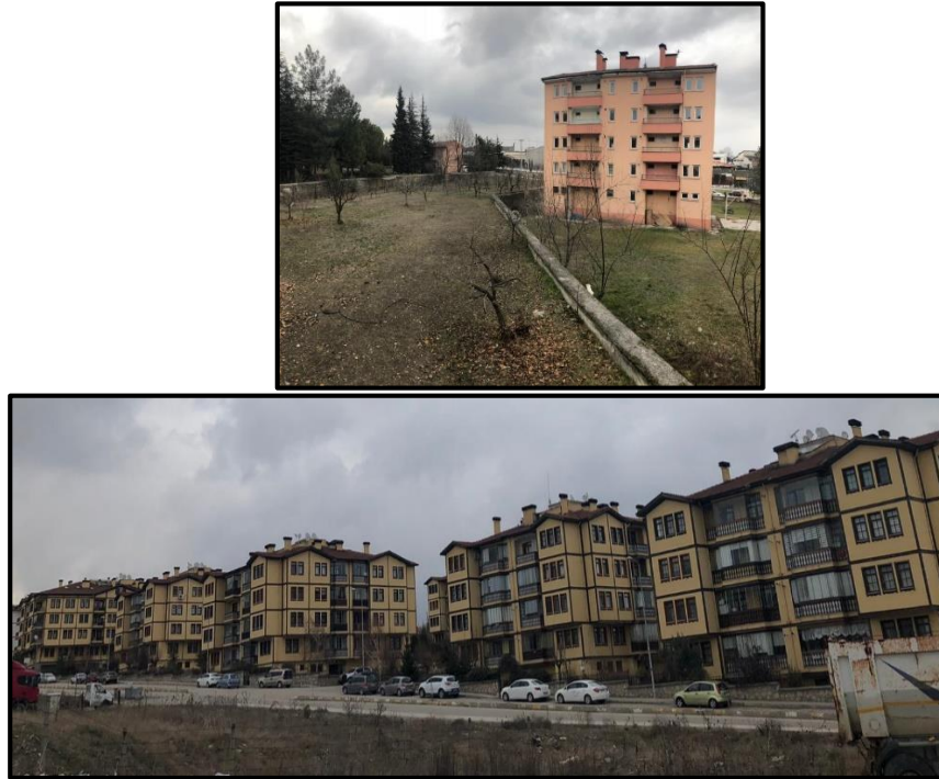
Şekil 8. Emek Mahallesinde ki işçi konutları ve silüeti bozan yapılaşmalar (Orijinal, 2021)
