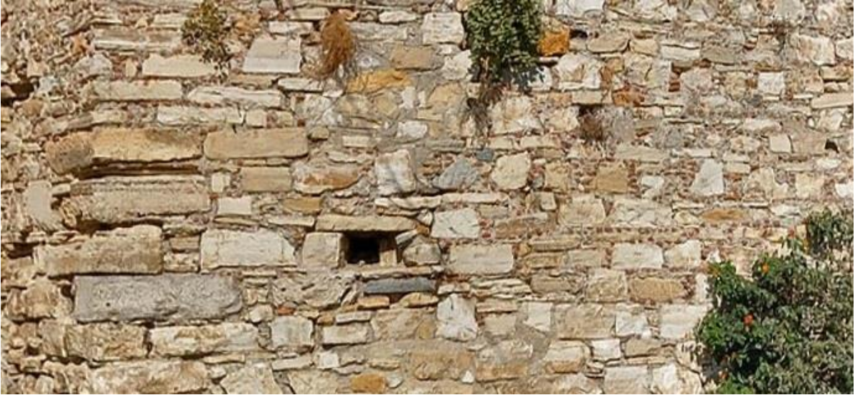
Şekil 18. Kuşadası Şehir Surları güneybatı hattının köşesinden duvar işçiliği ve derz detayı.
