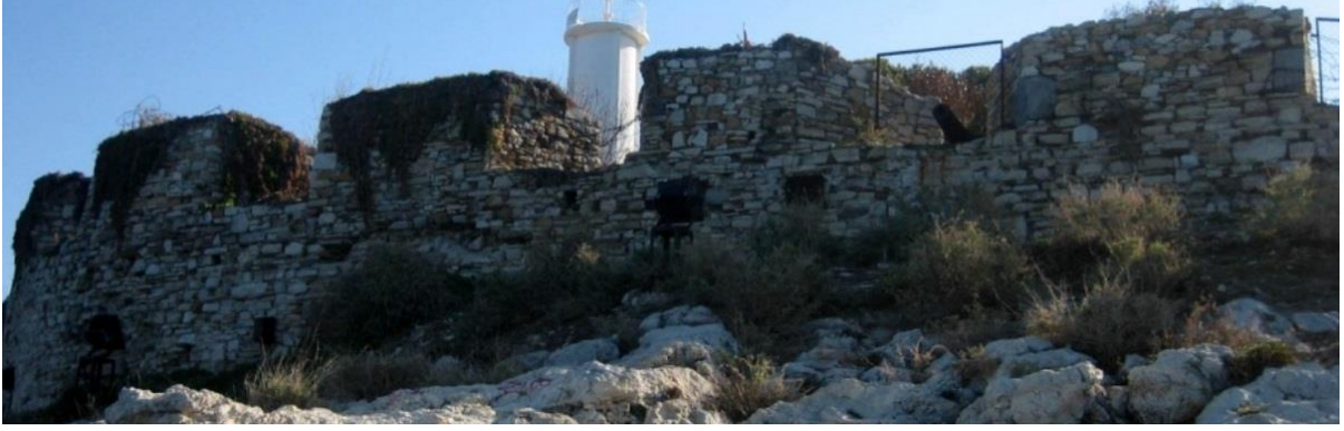
Şekil 3. Güvercinada Kalesi dış surlarının batı bölümündeki içten dışa genişleyen tipte top mazgalları (Tok, 2014: 78).
