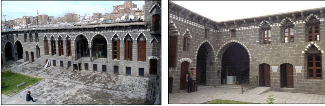
Şekil 6. Harem bölümü kuzey kanadı ve kuzeydoğu yönündeki mutfak (Işık, 2021)
