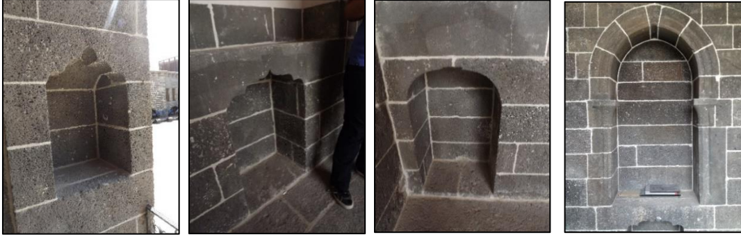
Şekil 16. Cemilpaşa Konağındaki niş örnekleri (Işık, 2021)
