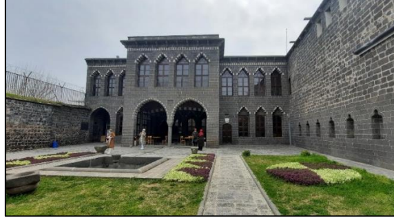
Şekil 5. Cemilpaşa Konağının Selamlık bölümü (2021)
