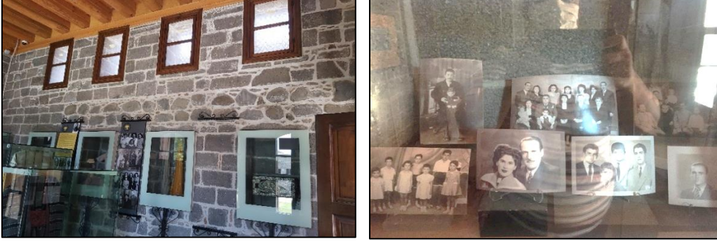
Şekil 24. Cemilpaşa Konağı'nda restorasyon sonrası teşhir salonuna çevrilen mekânlar (2021)
