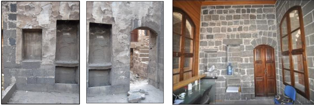
Şekil 13. Cemilpaşa Konağı Selamlık bölümündeki kahve ocağı mekânı (Halifeoğlu, 2011, 2021)
