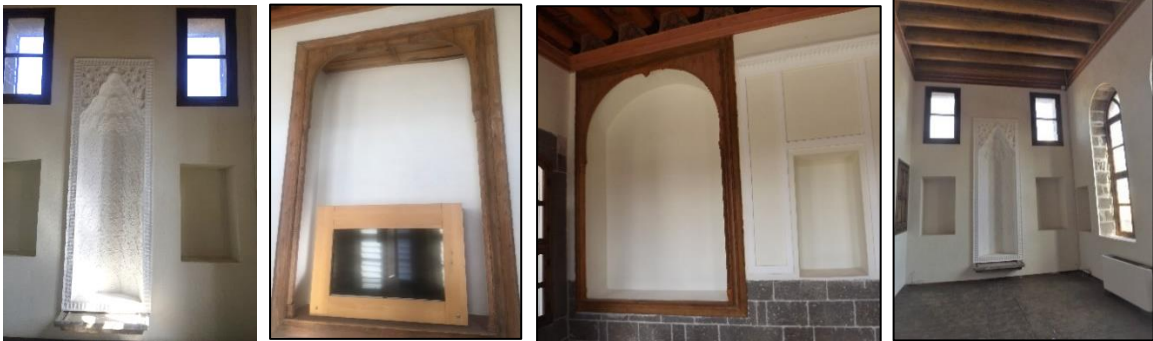
Şekil 15. Cemilpaşa Konağındaki yüklük ve süslü niş örnekleri (Işık, 2018)
