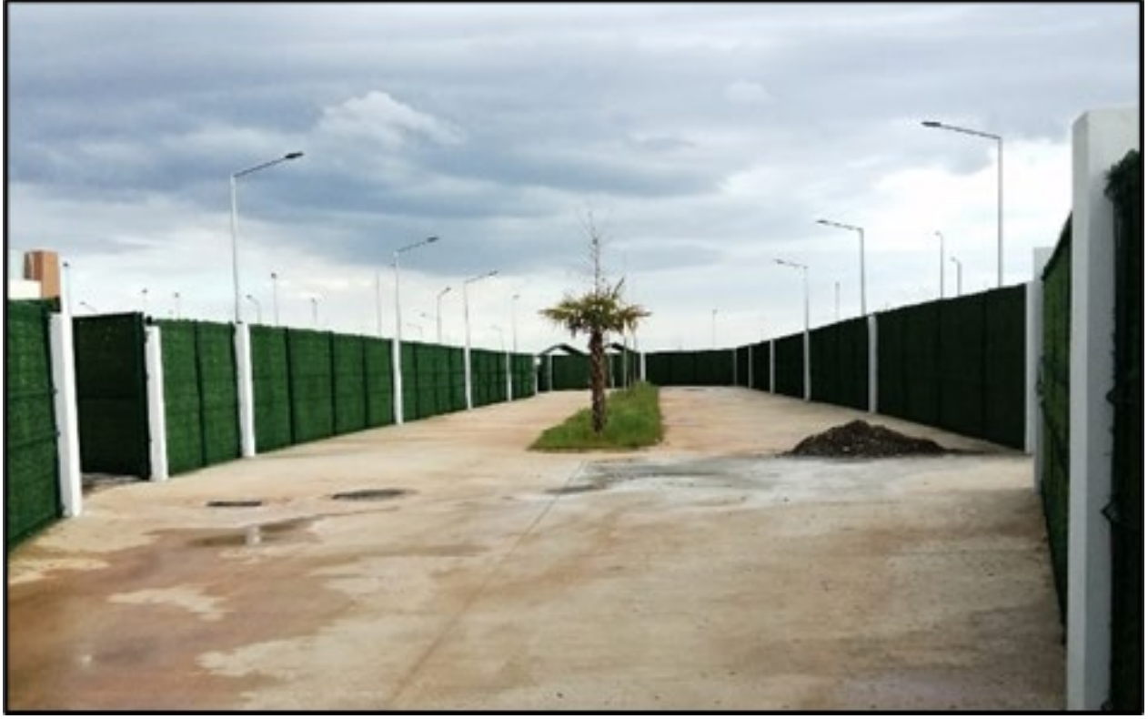
Şekil 9. Ayırıcı duvarlarla ortaya çıkan avlu (Orijinal, 2021)
