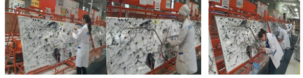
b) Kablo Döşeme Aşaması
