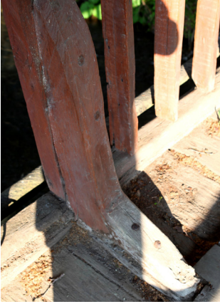
Fot. 16. Kastamonu-Bozkurt İlişi Cumayanı Köprüsü tabliyesinden ayrıntı (L şeklindeki payanda).
