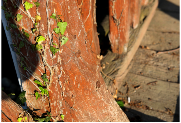
Fot. 17. Kastamonu-Bozkurt İlişi Cumayanı Köprüsü tabliyesinde payanda ayrıntısı)
