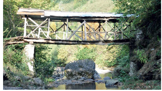
Fot. 28. Ordu - Akkuş Kapılı Kibar (Bek) Köprüsü (Tali, 2019, 212).
