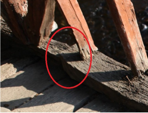
Fot. 22. Kastamonu-Bozkurt İlişi Cumayanı Köprüsü tabliyesinde ana kiriş birleşme ayrıntısı (düz boy birleştirme).
