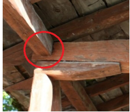
Fot. 23. Kastamonu-Bozkurt İlişi Cumayanı Köprüsü çatı birleşme ayrıntısı (kanallı birleştirme).
