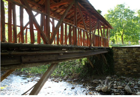
Fot. 8. Kastamonu-Bozkurt İlişi Cumayanı Köprüsü mansab yüzü.
