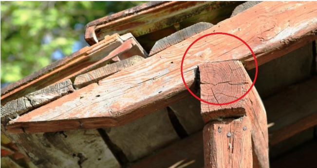
Fot. 24. Kastamonu-Bozkurt İlişi Cumayanı Köprüsü çatı birleşme ayrıntısı (kertmeli birleştirme).
