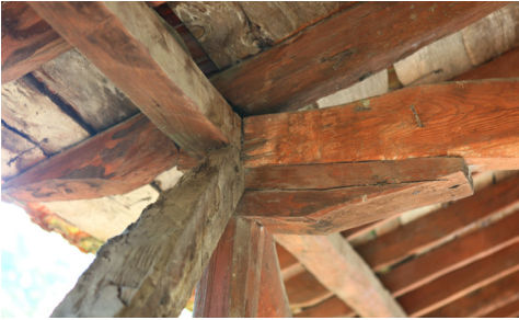
Fot. 18. Kastamonu-Bozkurt İlişi Cumayanı Köprüsü çatı ayrıntısı (aşık kirişi, mertek, direk, yastık, payanda, gergi birleşmeleri).
