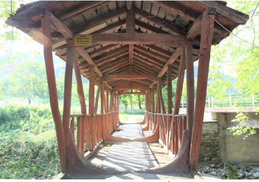
Fot. 10. Kastamonu-Bozkurt İlişi Cumayanı Köprüsü doğu cephesi.
