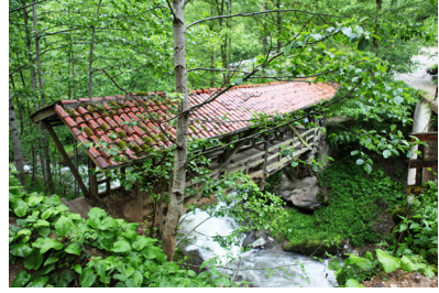
Fot. 38. Trabzon - Çaykara Eğridere Köyü Kiremitli Köprü.
