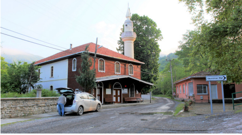
Fot. 2. Kastamonu-Bozkurt İlişi Cumayanı Camii
