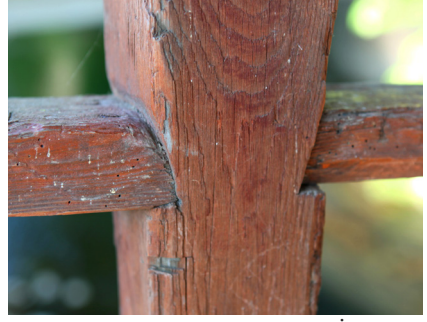
Fot. 15. Kastamonu-Bozkurt İlişi Cumayanı Köprüsü korkuluk ayrıntısı.
