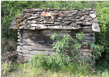
Fot. 41. Kastamonu – İnebolu'da geleneksel kırsal bir yapıda taş çatı kaplaması (say taşı / marla taşı).
