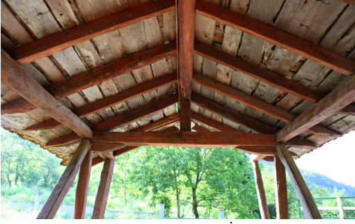
Fot. 14. Kastamonu-Bozkurt İlişi Cumayanı Köprüsü çatı ayrıntıları - batı kesim.
