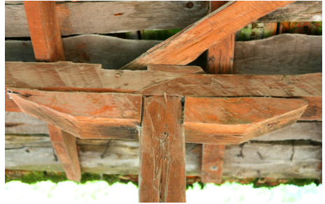
Fot. 19. Kastamonu-Bozkurt İlişi Cumayanı Köprüsü üst yapı ayrıntısı.
