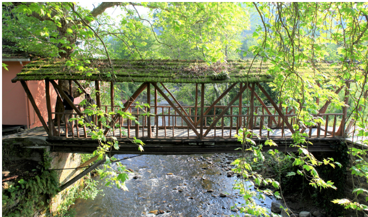
Fot. 7. Kastamonu-Bozkurt İlişi Cumayanı Köprüsü mansab yüzü.
