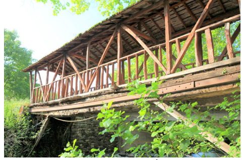
Fot. 9. Kastamonu-Bozkurt İlişi Cumayanı Köprüsü menba yüzü.
