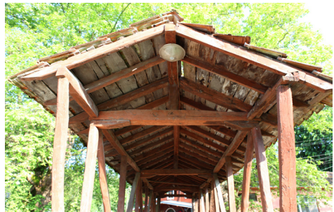
Fot. 13. Kastamonu-Bozkurt İlişi Cumayanı Köprüsü çatısı - batıdan.
