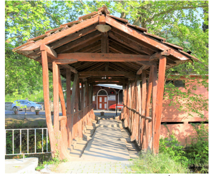
Fot. 11. Kastamonu-Bozkurt İlişi Cumayanı Köprüsü batı cephesi.
