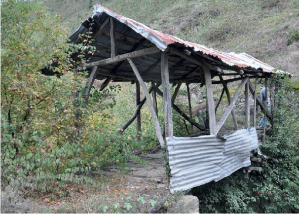
Fot. 31. Ordu – Kabataş Beylerli Köprüsü (Tali, 2019, 246)
