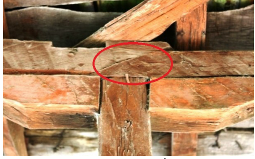
Fot. 21. Kastamonu-Bozkurt İlişi Cumayanı Köprüsü direk-yastık-aşık kirişi birleşme ayrıntısı (pahlı (şevli) boy birleştirme)
