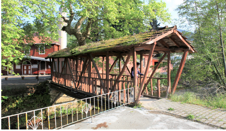
Fot. 5. Kastamonu-Bozkurt İlişi Cumayanı Köprüsü kuzeyden görünümü.
