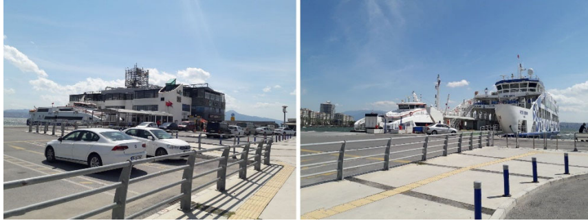
Görsel 8. Vapur iskelesi yolcu girişi, ofis ve restorandan bir görünüm.
