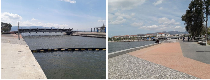
Görsel 28, 29. Bostanlı sahilini Bostanlı iskelesine bağlayan köprüden görünüm.
