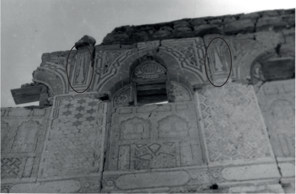
Fot. 10f. Sevâkin’de (Sudan) Osmanlı mimari örneklerinden Hurşid Efendi Evi, duvarlarda alçı bezemeler ve selvi ağaçları (BİMTAŞ).
