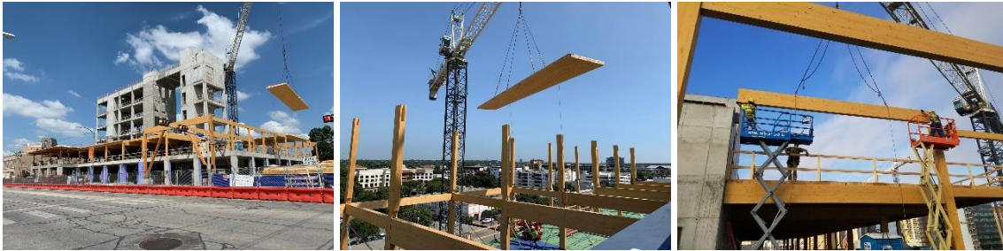
Şekil 3. Prefabrik olarak üretilen ahşap malzemenin montajı (Url 34, 2021)
