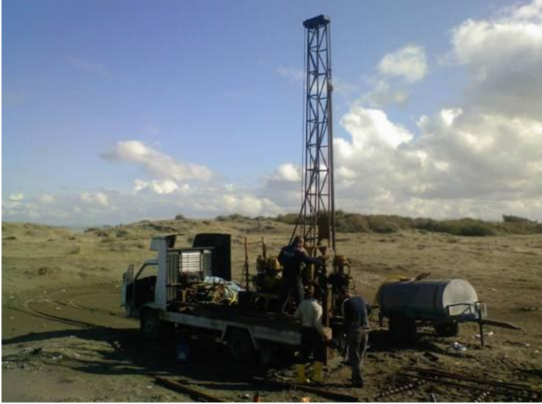
Şekil 6. Arazide SPT deneyine ait sondaj çalışması
