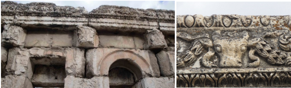
Görsel 13. Sarıkaya Roma Hamamı batı cephesi detayı (solda) ve arşitrav üzerindeki kabartmalar (sağda), 2009.
