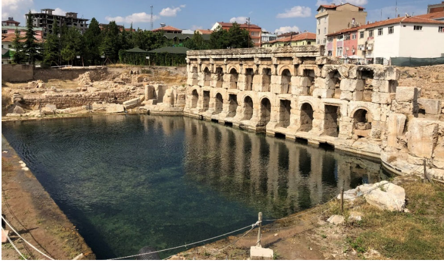
Görsel 15. Sarıkaya Roma Hamamı batı cephesi ve natatio/büyük havuz, 2020.
