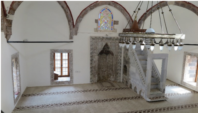
G. 5: Restorasyon Sonrası Mihrap ve Minberin Durumu (Polat, 2021)
