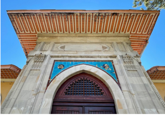
Foto. 7: Edirne İttihat ve Terakki Kulübü Binası, (Halk Eğitim Merkezi Binası), Ana Giriş Kısmı Detay
