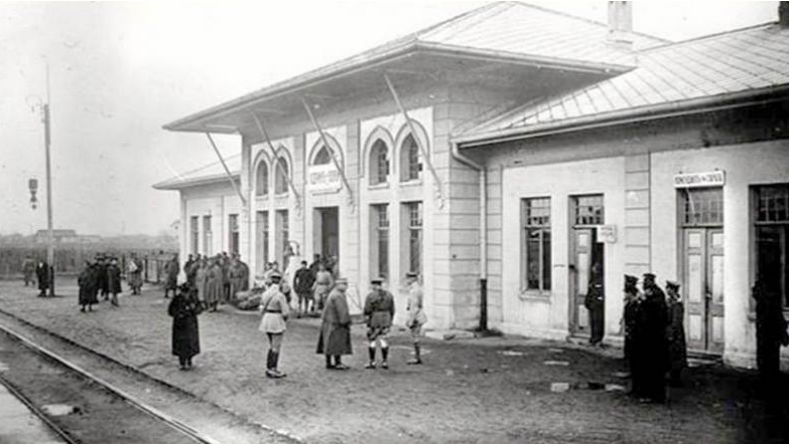
Foto. 18: 1923 Tarihli Edirne Eski İstasyon/Gar Binası, Arka Cephe (Peron) Görünümü Kaynak: https://project-haskovo-edirne.eu/tr
