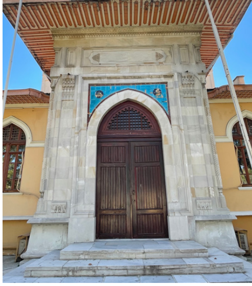
Foto. 6: Edirne İttihat ve Terakki Kulübü Binası, (Halk Eğitim Merkezi Binası), Ana Giriş Kısmı
