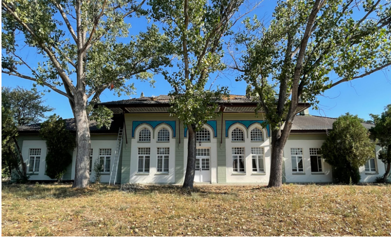
Foto. 21: Edirne-Karaağaç Eski İstasyon Binası, Arka Cephe Görünümü
