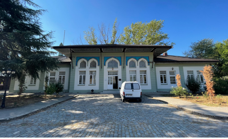
Foto. 20: Edirne-Karaağaç Eski İstasyon Binası, Ön Cephe Görünümü
