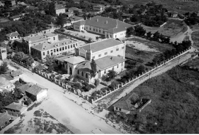
Foto. 1: Edirne İttihat ve Terakki Binası (Halk Eğitim Merkezi Binası),
