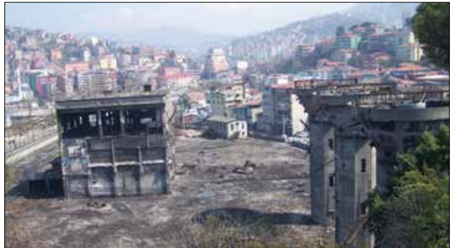
Fotoğraf 42: Zonguldak Liman'da yer alan Merkez Lavuar Tesisi, Kriblaj Binası (Yıkımdan Sonra) (TTK Arşivi, 03.04.2007) / Central Coal Washing Facility in Zonguldak Port, Coal Crushing House (After)
