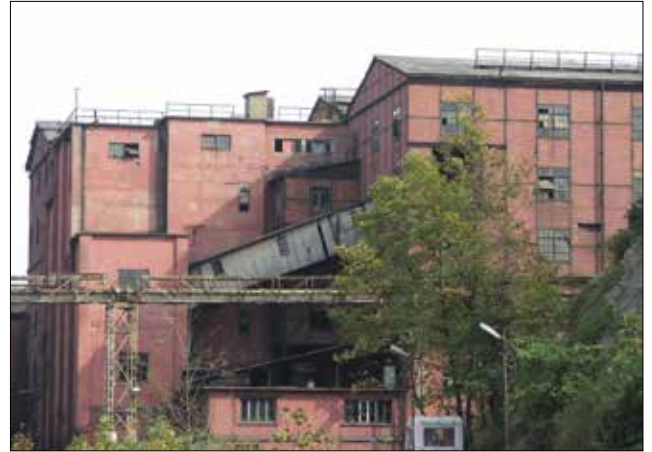
Fotoğraf 39: Zonguldak Liman'ında yer alan Merkez Lavuar Tesisi (Yıkımdan Önce) (Muhsin Maden Arşivi, 02.01.2006) / Central Coal Washing Facility in Zonguldak Port (Before Demolition)
