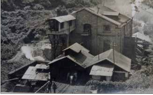
Fotoğraf 21: Asma-Dilaver Taşkömürü İşletme Müdürlüğü Lavuar Binası (Muhsin Maden Arşivi) / Asma-Dilaver Hard Coal Operation Management Coal Washing Building
