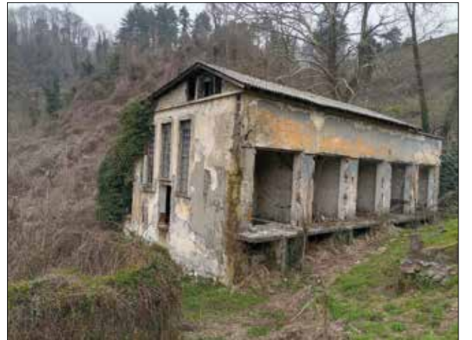
Fotoğraf 32: Asma-Dilaver Taşkömürü İşletme Müdürlüğü (3239) Trafo Malzeme Ambarı (Aydın Ekinci Arşivi, 01.04.2022) / Asma-Dilaver Hard Coal Operation Directorate Transformer Material Warehouse
