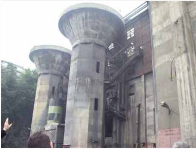
Fotoğraf 40: Zonguldak Liman'da yer alan Merkez Lavuar Tesisi (Yıkımdan Önce) (Muhsin Maden Arşivi, 13.11.2006) / Central Coal Washing Facility in Zonguldak Port (Before Demolition)
