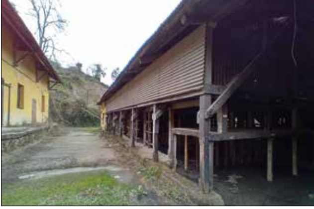
Fotoğraf 27: Asma-Dilaver Taşkömürü İşletme Müdürlüğü (3233) Malzeme Salaşı (Aydın Ekinci Arşivi, 01.04.2022) / Asma-Dilaver Hard Coal Operation Directorate Material Warehouse
