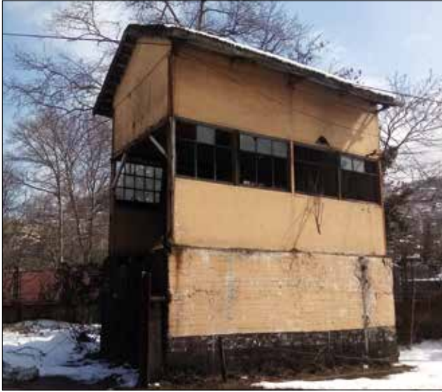
Fotoğraf 18: Vinç Binası (Aydın Ekinci Arşivi, 21.03.2022) / Crane Building
