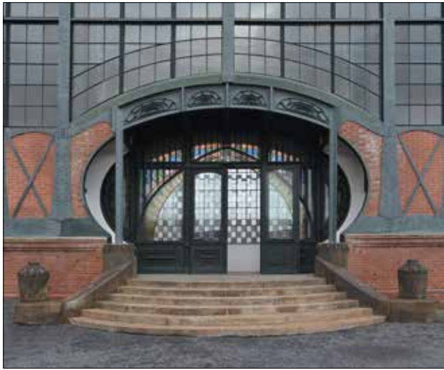
Fotoğraf 3: Zollern II/IV Makine Salonu (Merve Varol Can Arşivi, 21.02.2020) / Zollern II/IV Machine Hall
