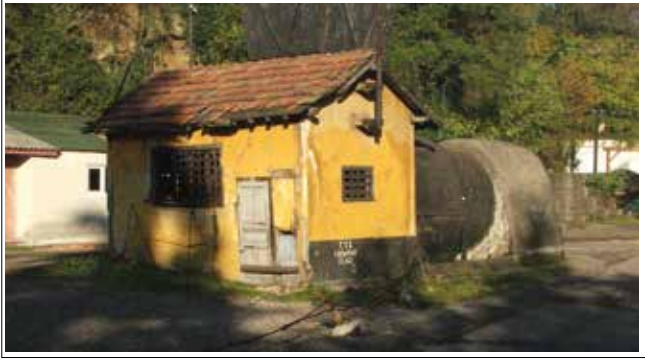
Fotoğraf 19: Pervane Binası (TTK Arşivi, 2009) / Propeller Building
