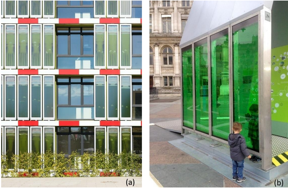
Şekil 1. Düz panel biyokütle üreten cephe uygulamaları (a) Bio binası, (b) Symbio2 Binası ( Kaynak: (a) Syn.de.Bio, 2014, (b) Symbio2 Biofacades, 2015).
