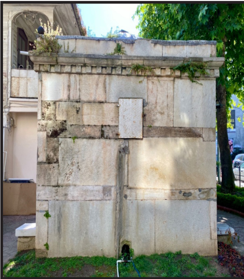
Ek-7 : Şehitler Çeşmesi'nin Doğu Cephesi. Kaynak: Cenk Demir Özel Arşivi.
