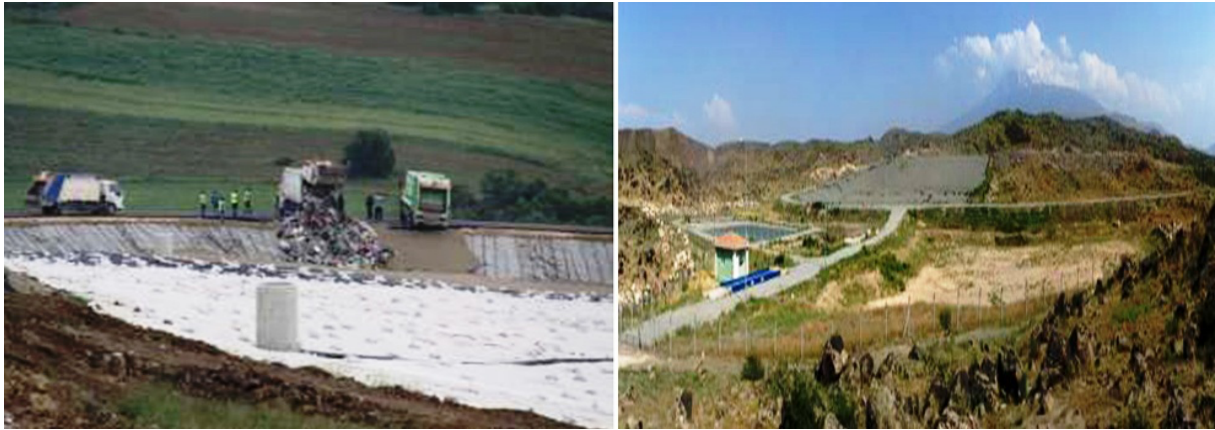
Şekil 4. İğdır Katı Atık Tesisi.
