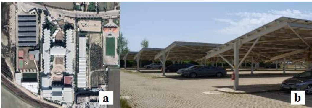
Şekil 4. a. Kampüs ve kuzey batısında bulunan otoparkın uydu görüntüsü, b. Otopark üzerine kurulu GES
