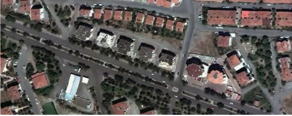
Şekil 8: Kentsel Döşüm Ödül İnşaat Proje Alanı (Citysurf-Globe, 2013 uydu fotoğrafı)
