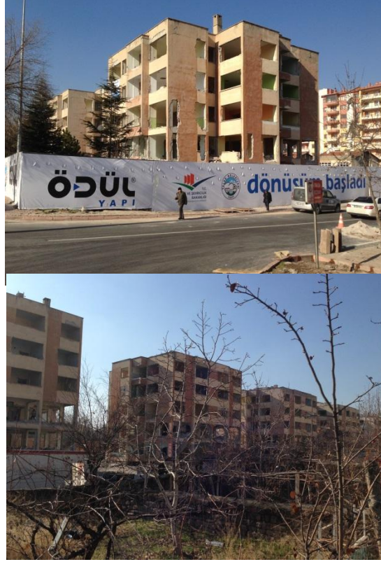
Şekil 9 a-b: Ödül İnşaat Kentsel Döşüm Proje Alanı (Baydoğan, 2013)
