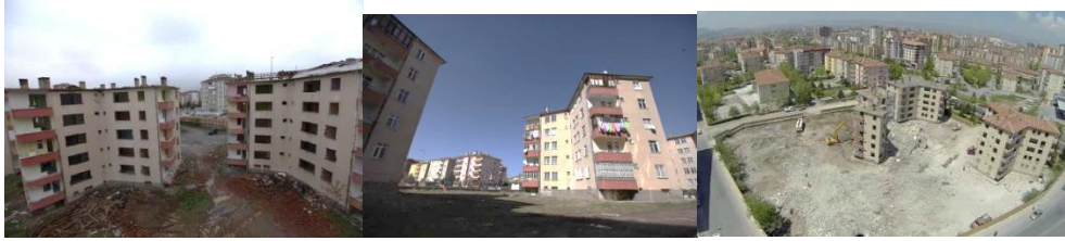
Şekil 11 a-b-c: AFM İnşaat Kentsel Döşüm Proje Alanı ( http://www.afminsaat.com/pages.php?e=recycle , erişim 28.12.2013)
