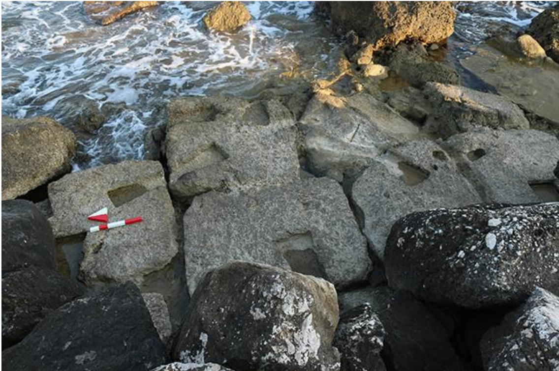
Fig. 7: Aigeai Deniz Kalesi, liman mendireği kırlangıçkuyruğu kenetli bloklar.
