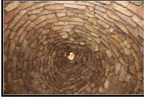
Foto 27. Harran Evlerinin Tuğladan İnşa Edilmiş Konik Çatısı.
