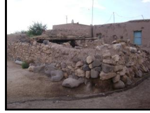
Foto 16. Yığma Taştan İnşa Edilmiş Bir Gom (Açık Ağıl) (Yatırtepe Köyü).
