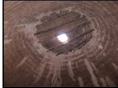
Foto 6. Ahşap Malzeme Kullanılmış, Küt ve Kesik Kubbe Tipi Çatı.
