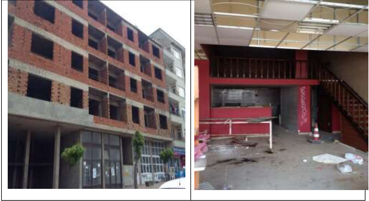
Şekil 6. Yarım kalmış yapıya ait fotoğraflar (a) ön cephe( b) zemin kat giriş
